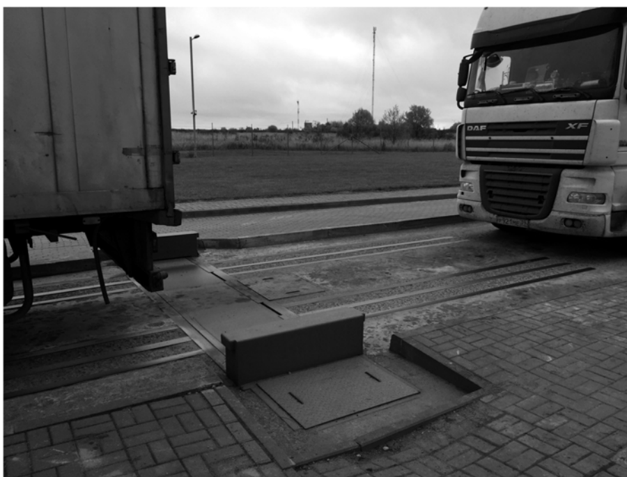
Рис. 4. Усиление подъездных путей продольными металлическими лонжеронами
